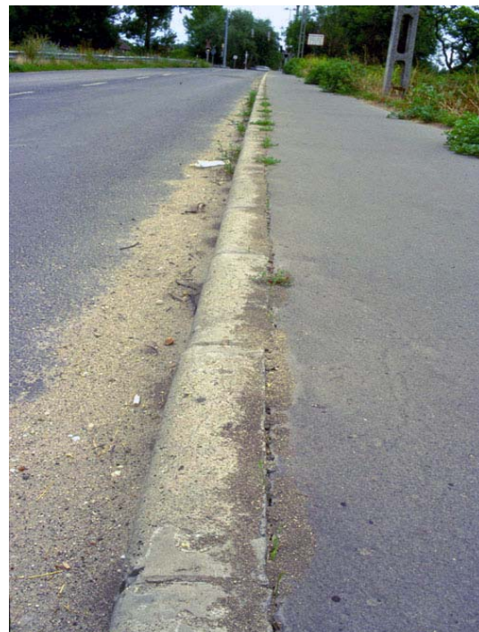
Figura 23. Población: Budatétény, Budapest, Hungría. Foto: Gergely Szóvényi. La presencia de hormigas se detecta por la arenilla acumulada en las rendijas.
