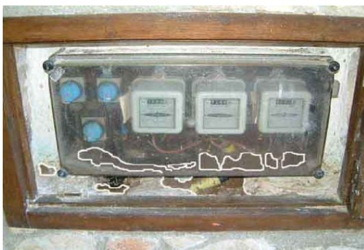
Figura 26. Población: Seva, España. La línea irregular blanca indica la zona de acumulación de hormigas muertas.
